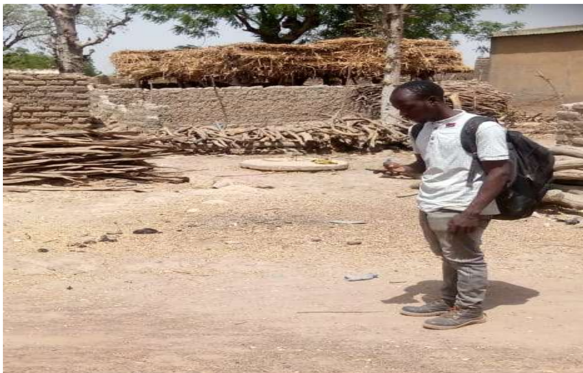
Photo 1: traçage de la ligne à l'aide du GPS et d'un smartphone
